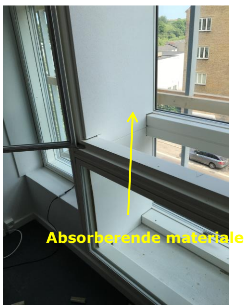
Figur 8 Absorberende materiale mellem forsatsvindue og eksisterende vindue
