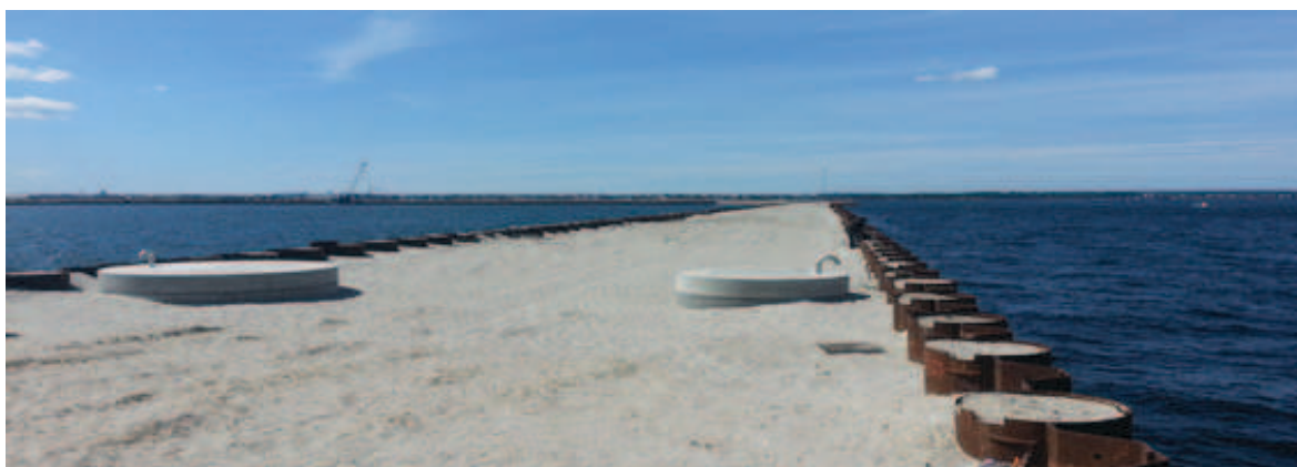
Figur 8: Eksempel på cellefangedæmning
