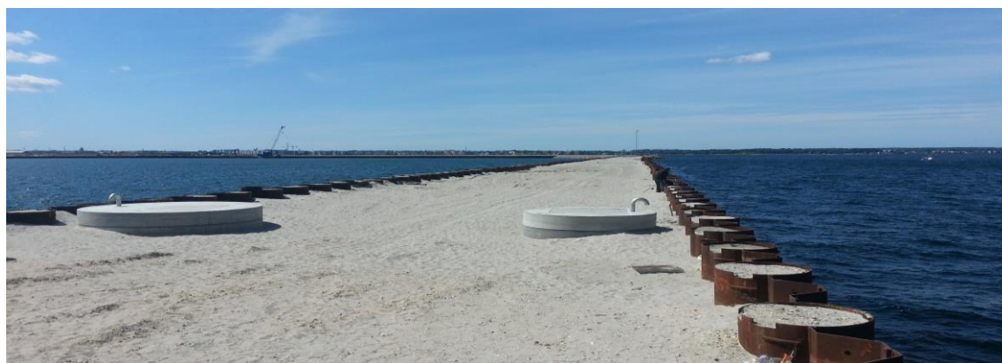
Figur 46: Eksempel på cellefangedæmning
