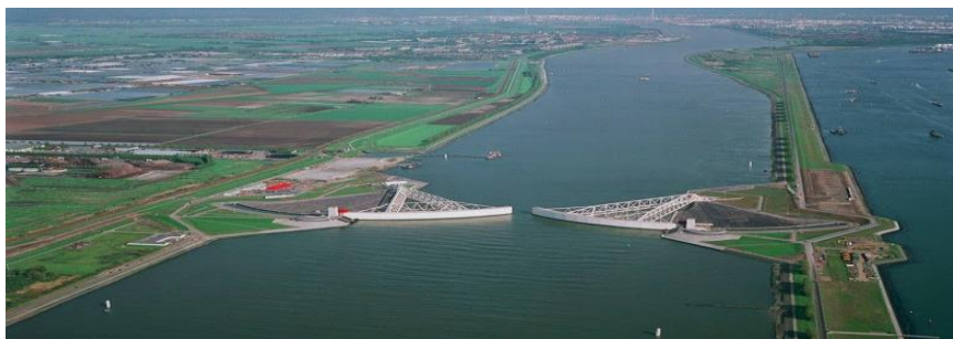
Figur 43: Vertikalt roterende porte, principskitse (venstre) og eksempel af implementeret portdesign fra Maeslantportene, Rotterdam (Google image, 2019d)
