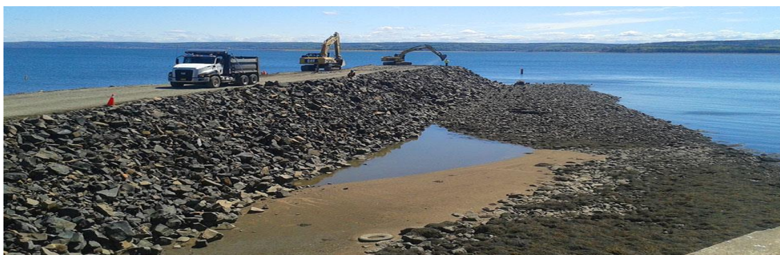
Figur 48: Billede af en stenkastning med impermeabel kerne (Google Image, 2019f)
