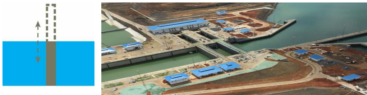
Figur 42: Skydeport, principskitse (venstre) samt eksempel af implementeret portdesign, Agua Clare portene, Panama (højre) (Google Image, 2019c)
