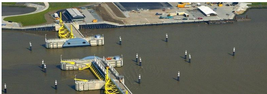
Figur 44: Horisontalt roterende sektioner, principskitse (venstre) og eksempel af implementeret portdesign fra Ems barrieren, Tyskland (højre) (Google image, 2019e)
