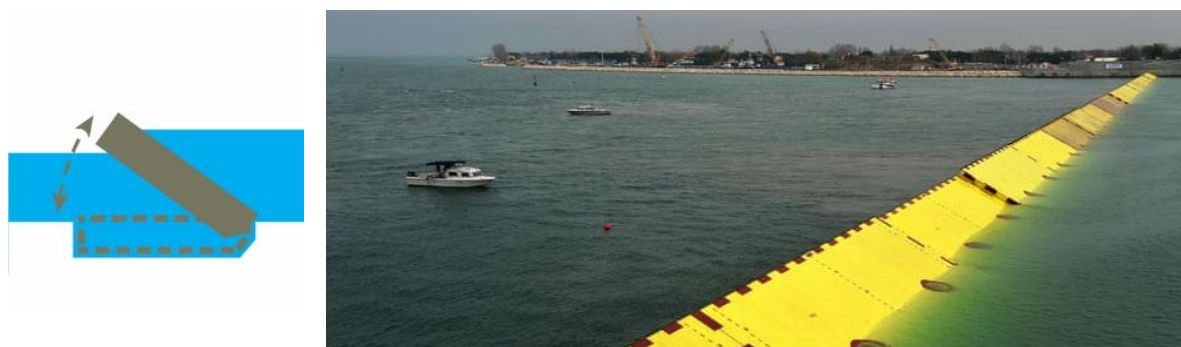
Figur 40: Horisontalt hængslede porte, principskitse (venstre) og eksempel af implementeret portdesign fra Venedig (højre) (Google image, 2019a)
