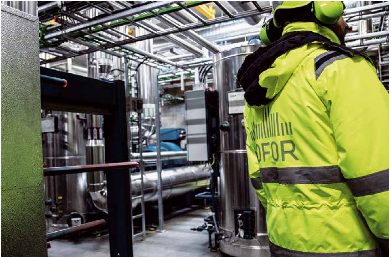
Demonstrationsprojektet, SVAF – Store Varmepumper til Fjernvarme, blev indviet i år og er et af flere projekter med store varmpumper, som HOFOR forsøger at udvikle.
