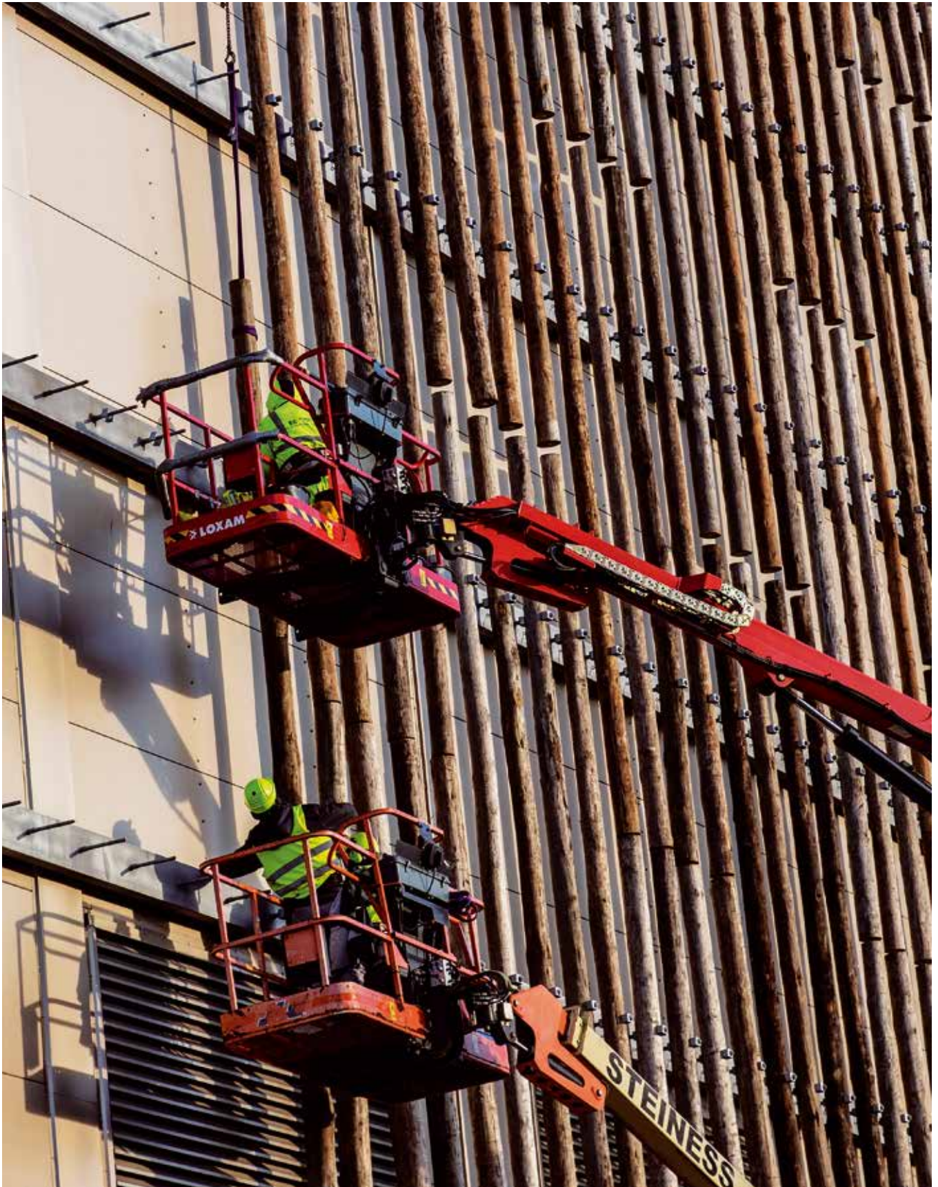
Facaden ved Amagerværkets nye kraftværksblok i gang med at blive beklædt udvendigt.
