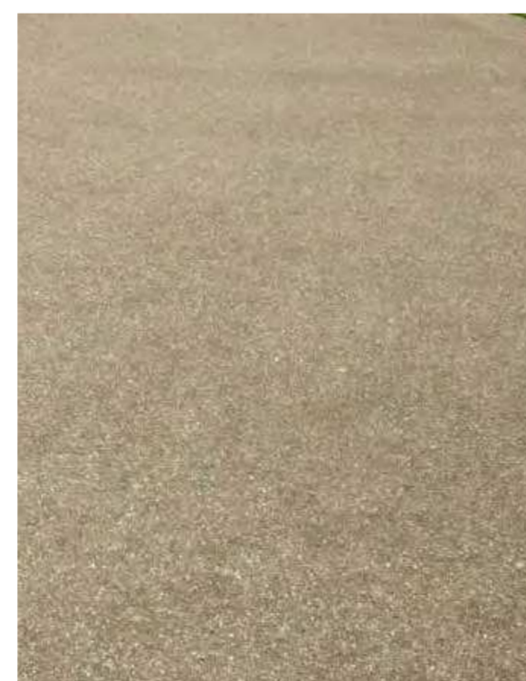
Slotsgrus Det primære stisystem anlægges i slotsgrus. Det kan bruges som både toplag og bærelag, det giver besparelser i både anlæg og drift. Samtidig bidrager grusbelægning med en særlig atmosfære, og en tydelig markering af at man bevæger sig ind i et natur-rum.
