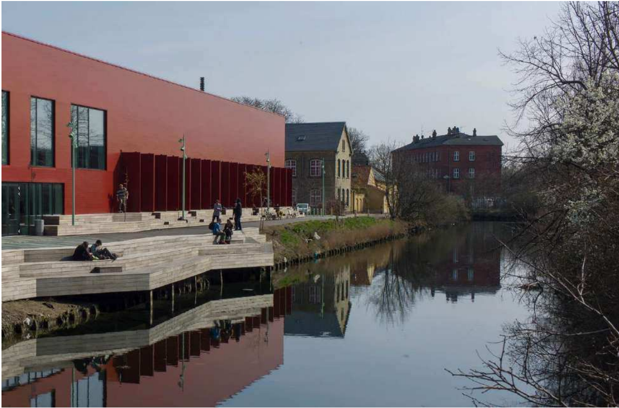
Eksisterende trappeophold ved Hal C
