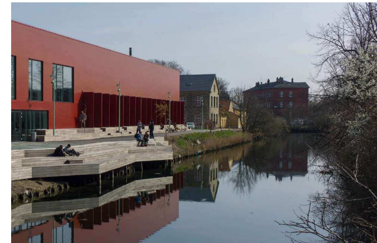
Eksisterende trappeophold ved Hal C
