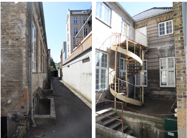
VESTERBROGADE 59 - FORPLADS, GÅRD OG HAVE, TILSTANDSFOTOS
