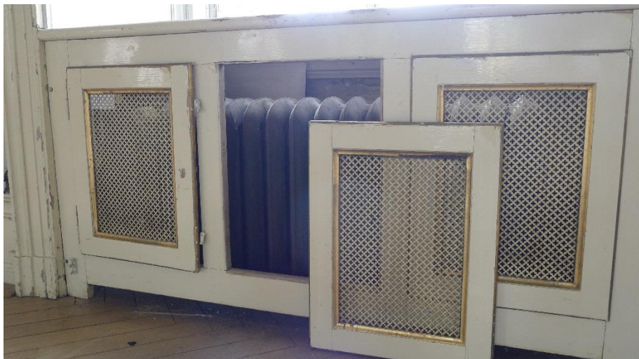
Der kan etableres lydabsorption bag radiatorskjulere.
