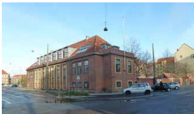
Skolen med beboelsesejendommen baggrunden, set fra hjørnet af Bardenflehsgade og Peter Vedels Gade.
