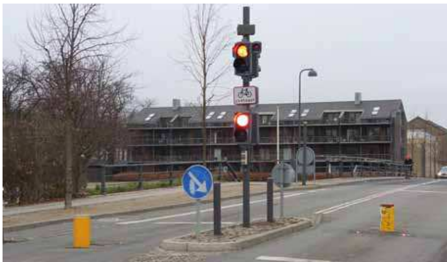
Den mekaniske bussluse syd for Frederiksholmsbroen.
