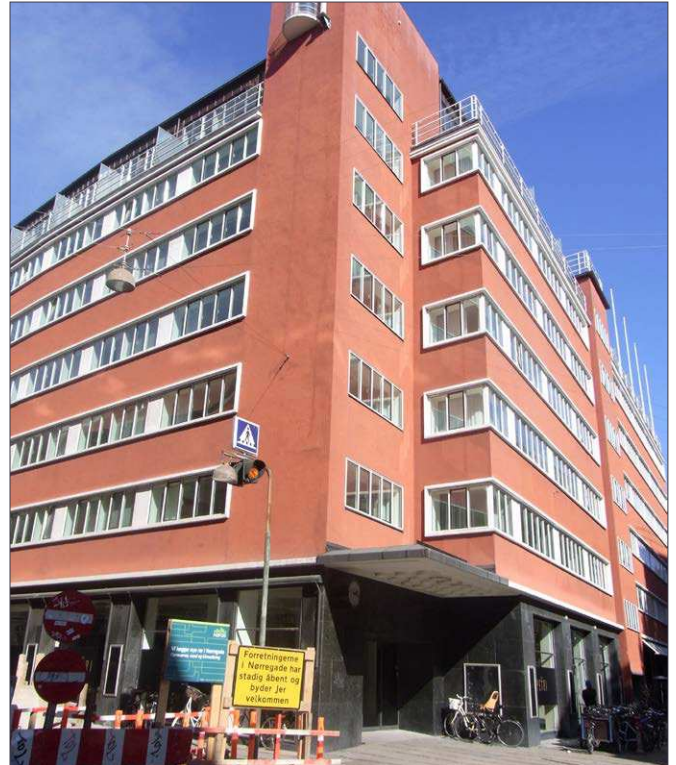
Hjørnet Nørregade/Krystalgade. Butiksarealerne i stuen står i dag tomme hen.
