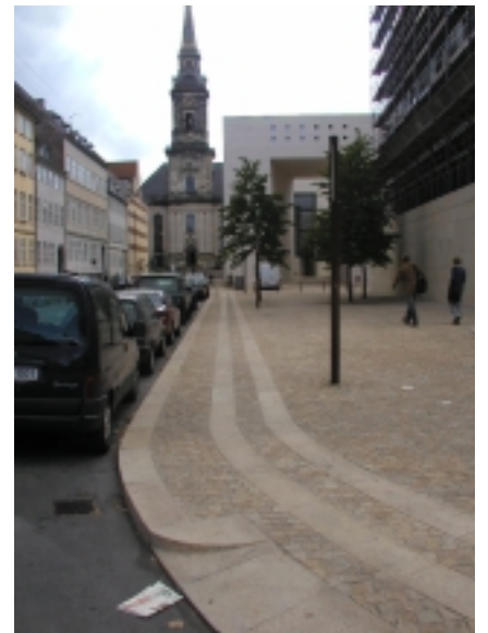
Fortovsbelægning langs Nordeas hovedsæde i kinesisk gul sten med bred bordurkant og bodurganglinier.
