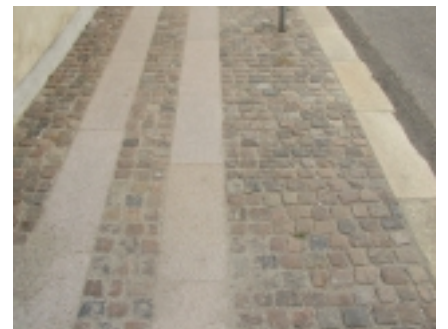
Fortov i Nicolai Eigtveds Gade: Bodurbånd og chauxsten i skandinavisk granit og fortovskant i kinesisk gul sten
