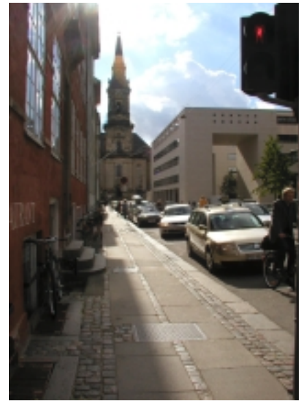
Traditionelt 'Christianshavner-fortov' af chauxsten, fortovsfliser og med bred bordurkant
