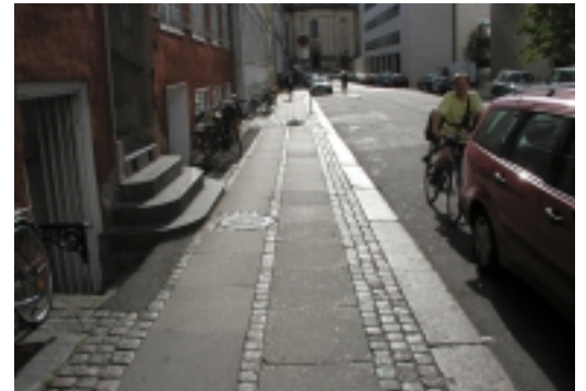
Eksisterende fortov med bred bordurkant rettes op med eksisterende materialer.
