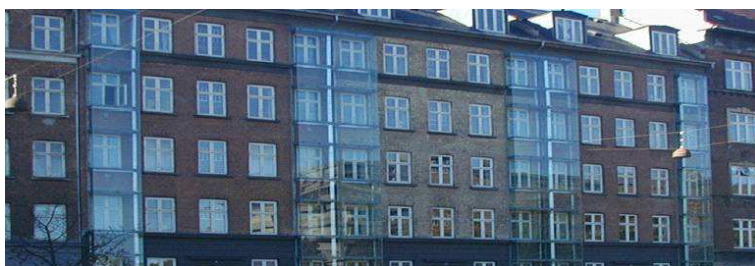
Eksempel på facadeinddækning fra Fredensgade
