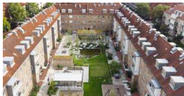
I gårdhaven ved Straussvej bliver regnvandet håndteret lokalt. Der er genbrugt natursten til permeable belægninger. Derudover er der genanvendt beton og spildtræ til klimasikring samt inventar. Samlet svarer det til en besparelse af 115 tons affald. Kilde: Fremtidens gårdhave ved Straussvej, BOGL, 2021.
