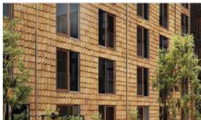
I forbindelse med byggeriet Teglgården blev 12.900 vingetegl nedtaget fra en eksisterende bygning og gemt. Det lykkedes at genbruge 1/3 af stenene 1:1 i nybyggeriet. Resten blev nedknust. Kilde: PensionDanmark, 2022.
