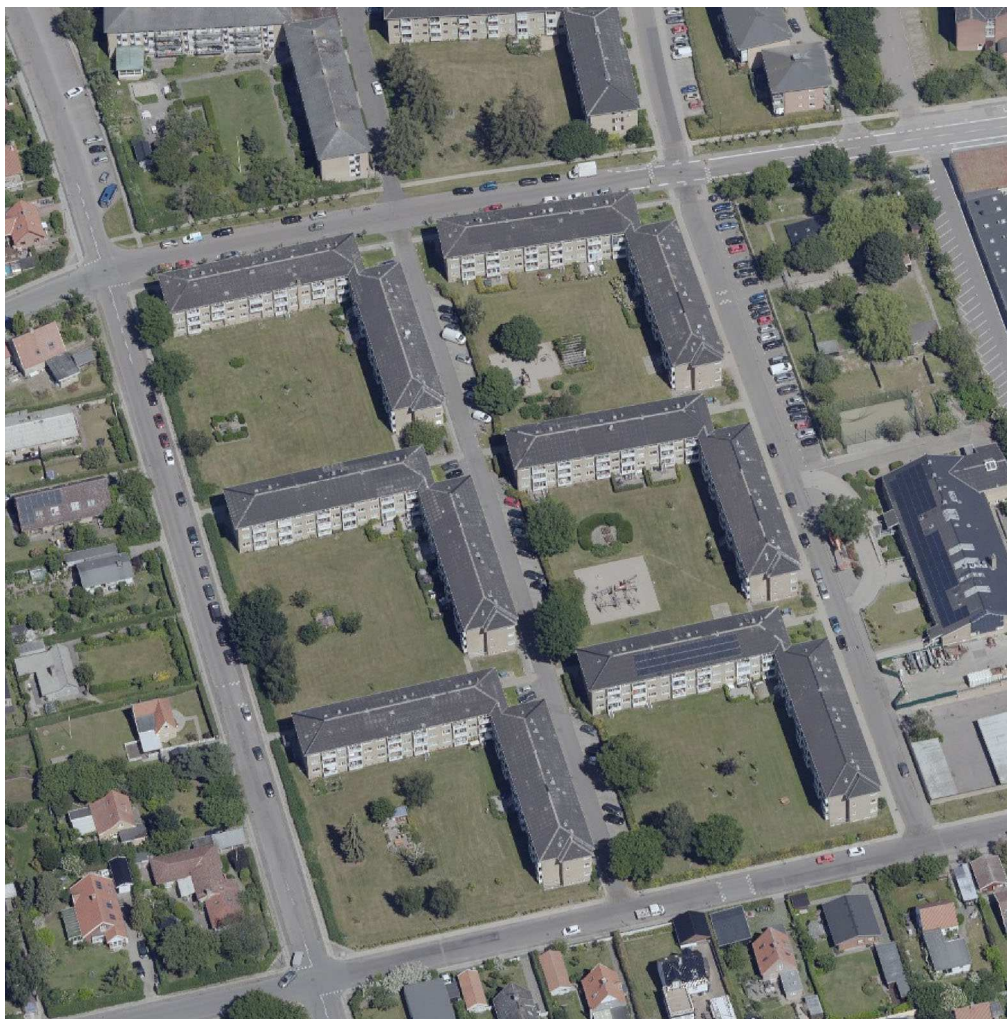
Eksisterende boligbebyggelse i tre etager, blok 16-21, Folehaven (set fra syd).
