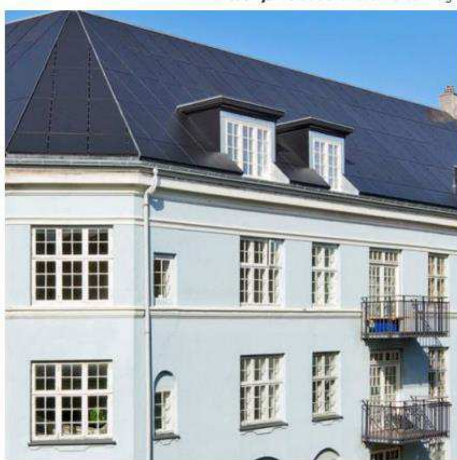
Sorte solceller som erstatning for tagbeklædning på Andreas Bjørns Gade 1
