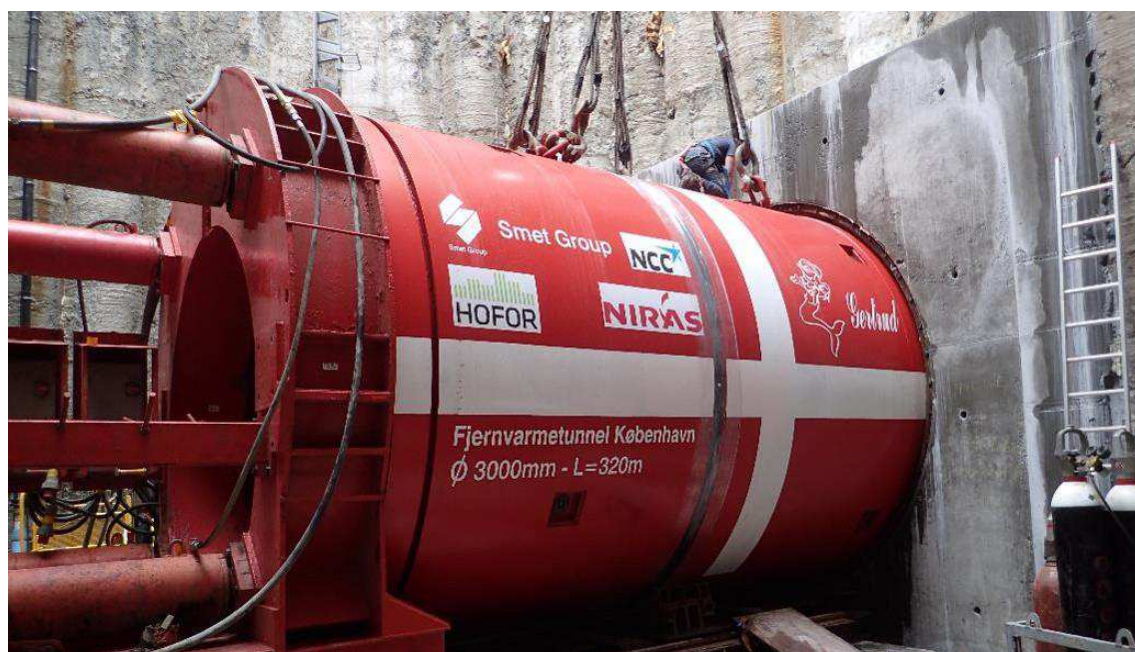
Figur 5.7 Tunnelboremaskine (TBM) klar til afsendelse gennem skaktvæggen.
