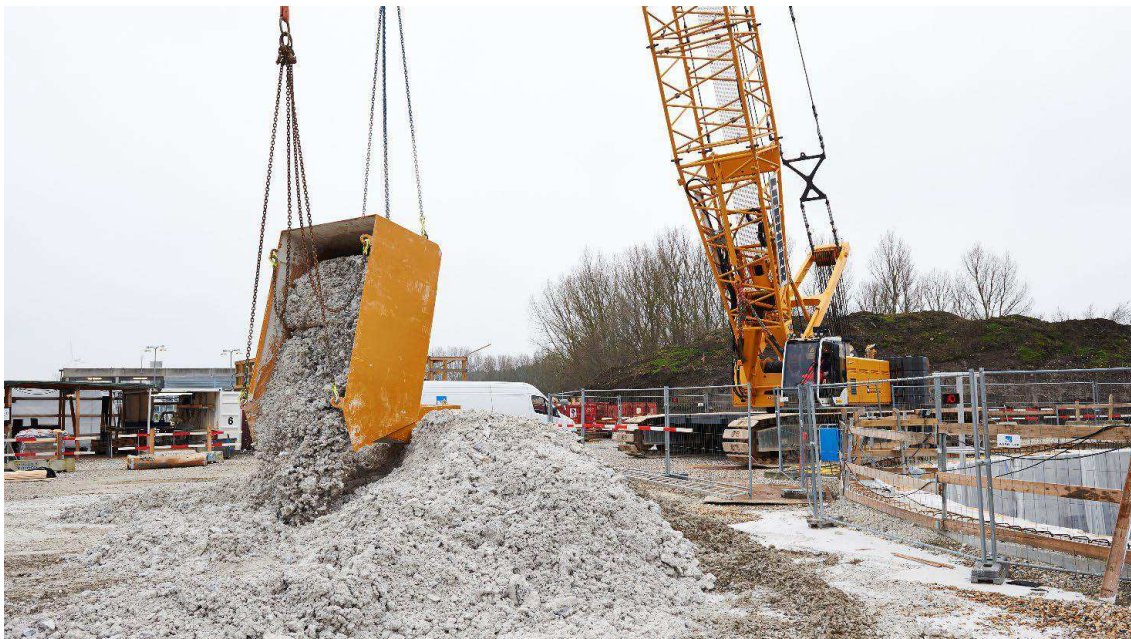
Figur 5.9 Tunnelmuck hejses op fra skakten til bortkørsel.
