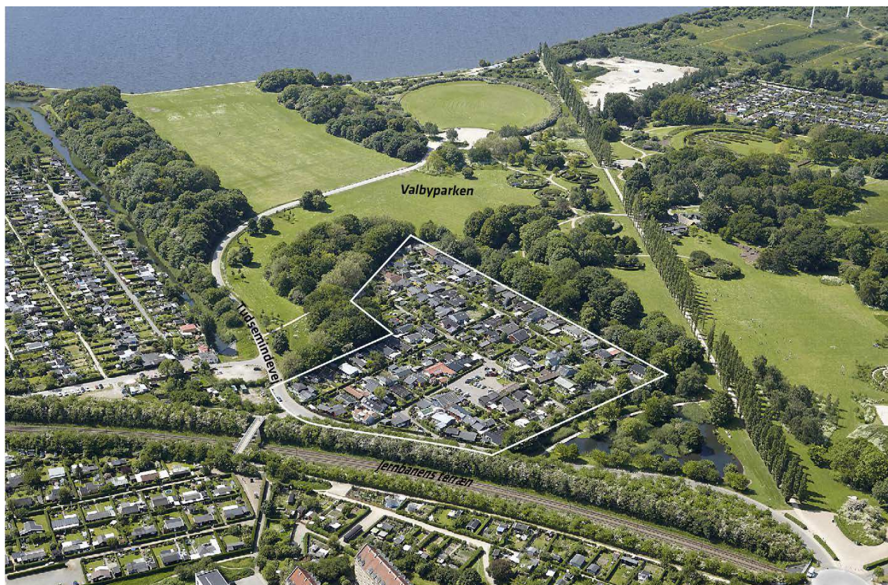
Luftfoto af Hf. Kalvebod set mod syd. Lokalplanområdet er vist med hvid linje. (JW Luftfoto, juni 2015)
