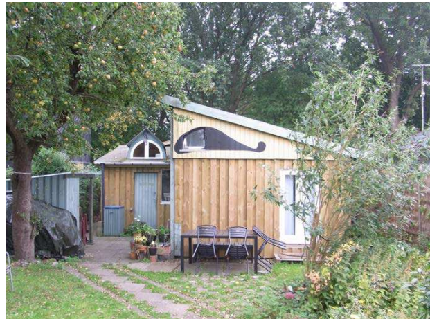
Selv de renoverede huse har sjove detaljer, der er med til at bevare kolonihavehuspræget.
