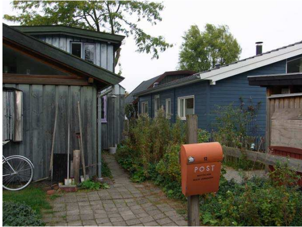
Husene ligger tæt, hvorfor det er vigtigt, at de brandsikres
