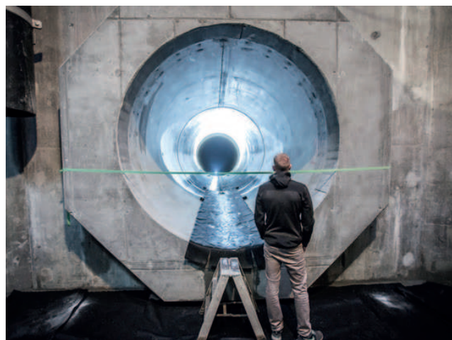
↑ Skybrudstunnel (foto HOFOR)
