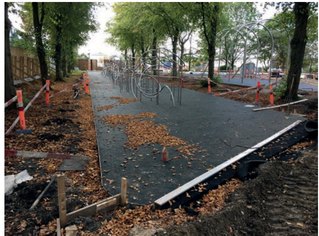
↑ Anlægsarbejde i Remiseparken
