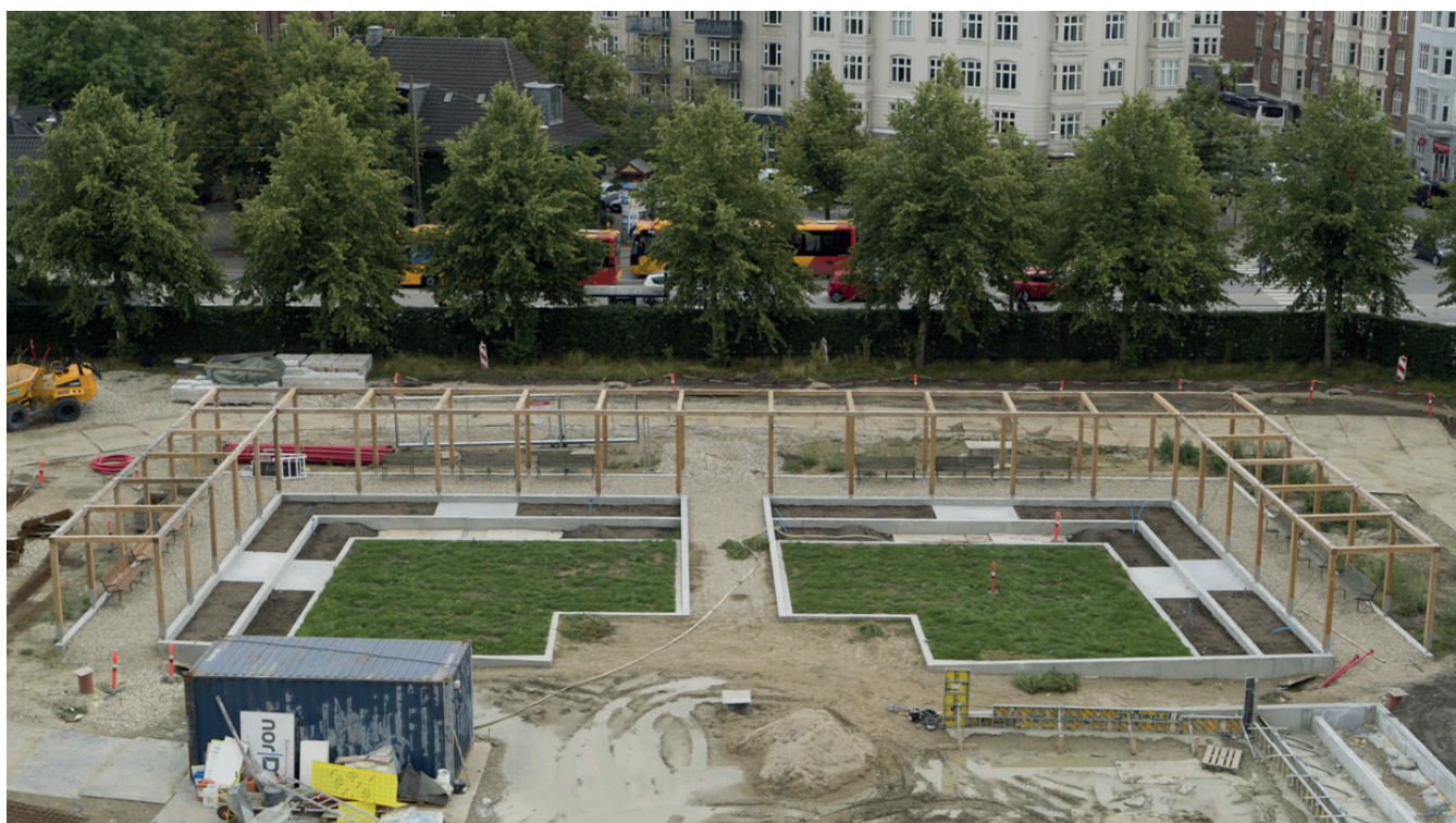
↑ Anlægsarbejde i Enghaveparken (foto HOFFMANN)
