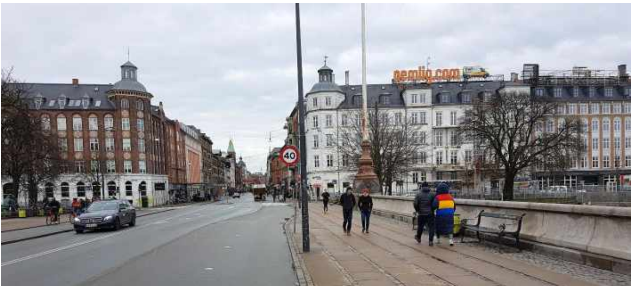
Her ses den ikoniske byport til Nørrebro. Sortedam Dossering 1 (til højre), som er tegnet af den nuværende stadsarkitekt i Københavns Kommune Camilla van Deurs oldefar, som var datidens stadsarkitekt. På billedet ses at facaden, med høj bevaringsværdi, bliver plastret til med standartaltaner.
