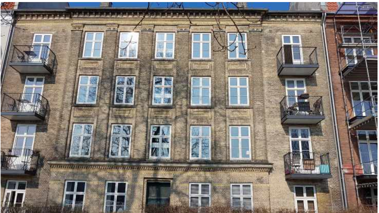
Peblinge Dossering 46 - opsætning af 6 stk. relativt små tilpassede altaner og døre. (efter min opfattelse den eneste altanopsætning på bevarelsværdig facade langs Peblinge Dossering, som arkitektonisk kan forsvares, dog er standartaltaner ikke egnet til denne fine facade).
