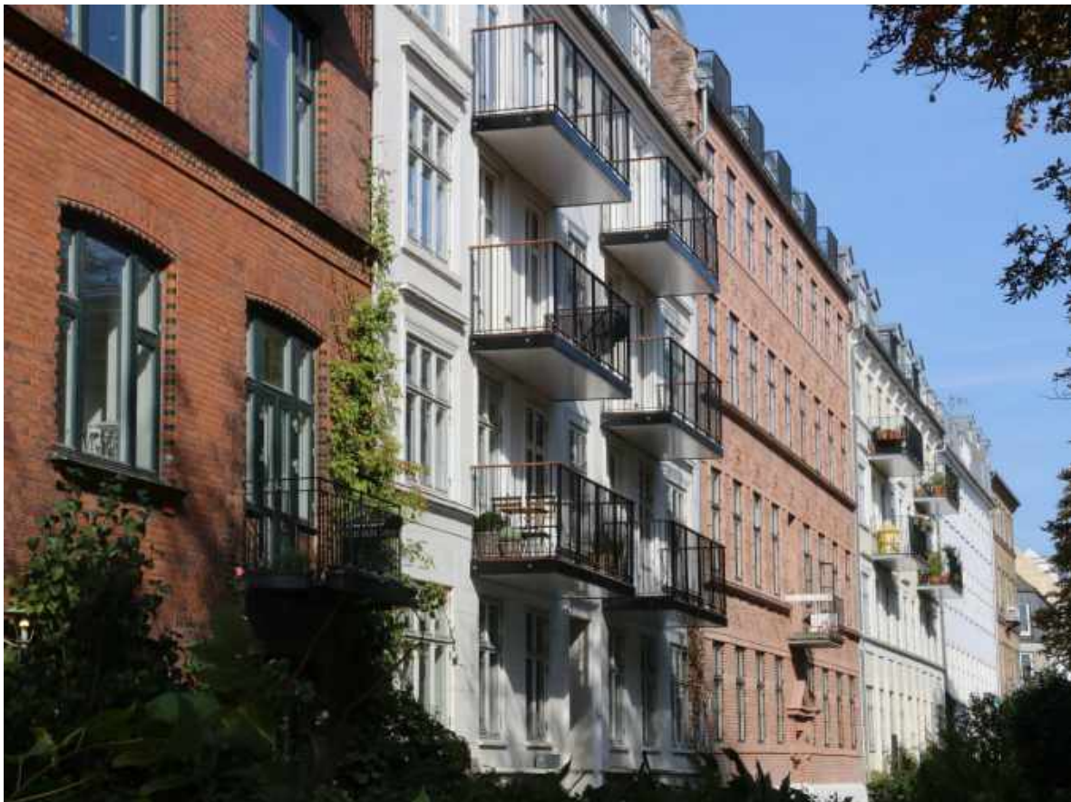
Peblinge Dossering 20 - et stykke af gesimsen er fjernet og altanerne er helt ude af proportion med den (engang) bevaringsværdige facade.
