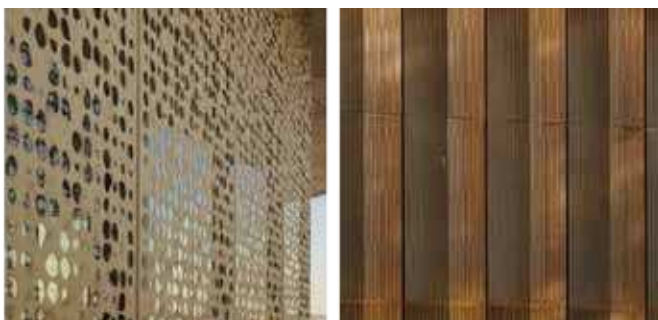
Eksempler på perforeret anodiseret aluminium. Ill. Arkitema.
