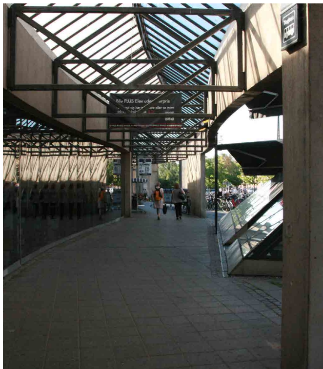
Eksisterende arkade langs Irma og Spejder Sport. Arkaden nedrives i forbindelse med det nye projekt.
