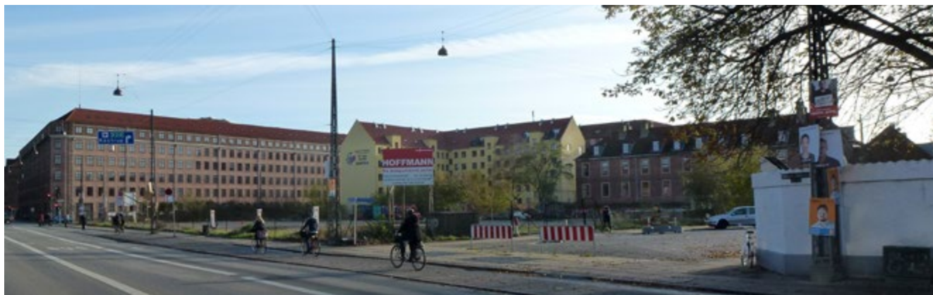
Området set fra Amager Boulevard, med den tomme grund samt beboelsesejendommen og skolen.
