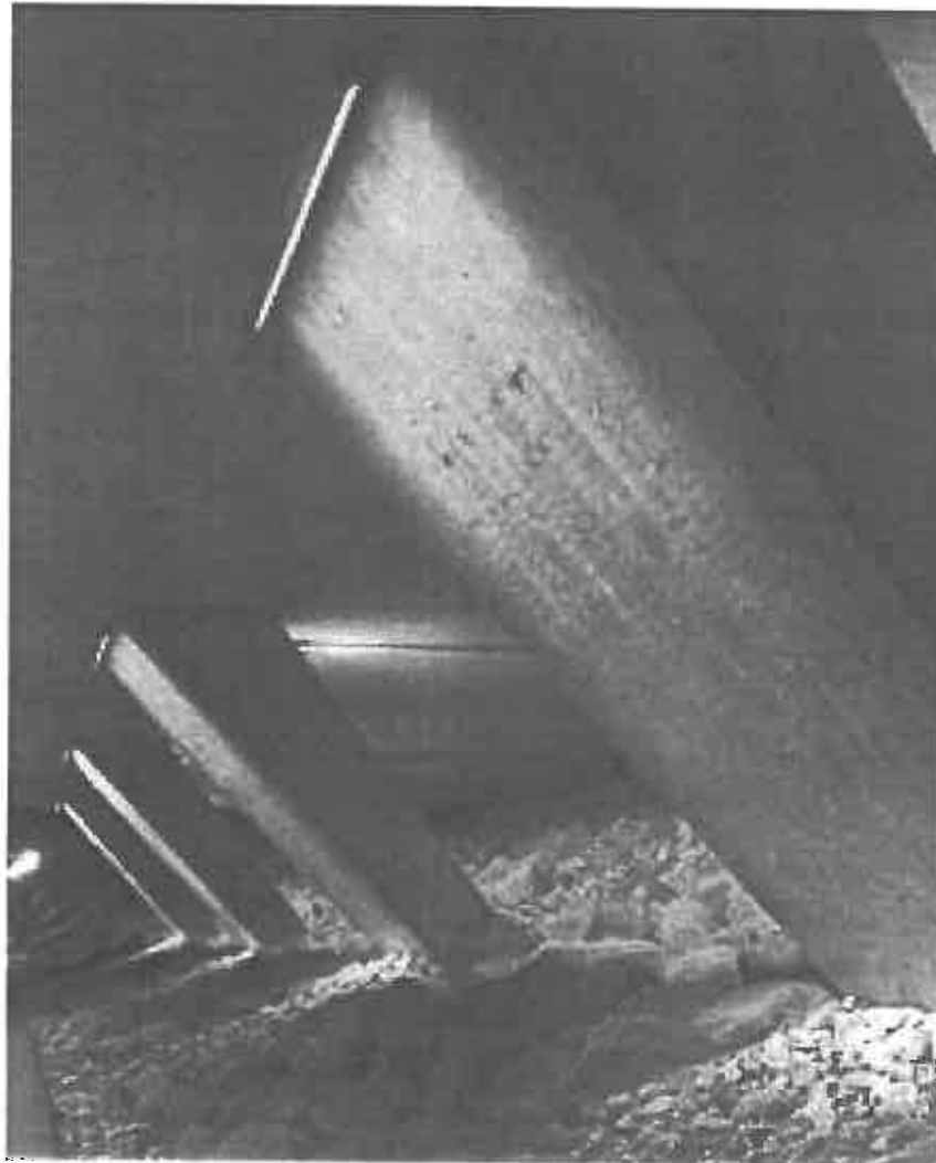
GLADSAXEVEJ: TRØKHEJSSKÅRSHOLE TUNNELBELYSNING
