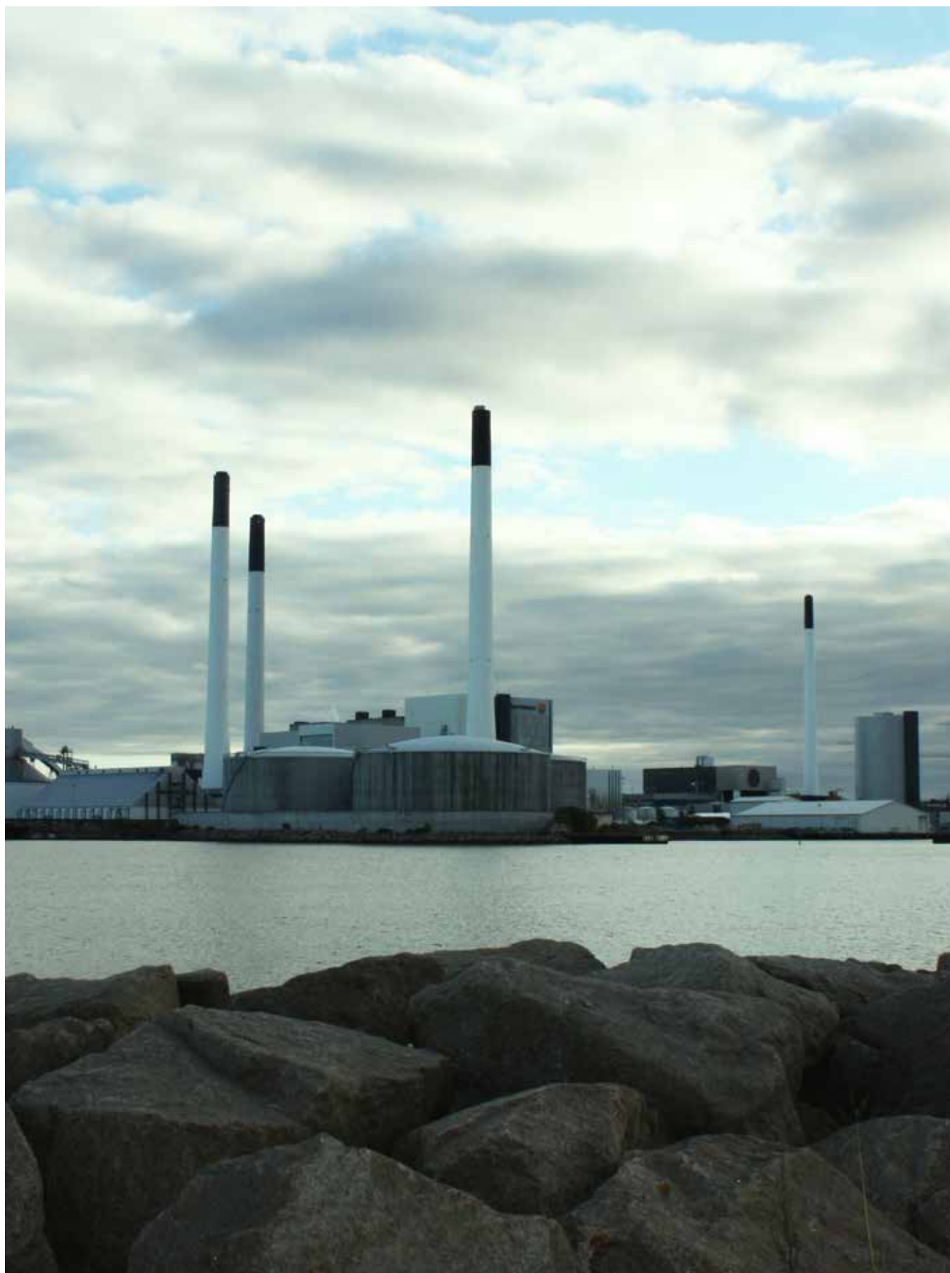
Amagerværket blev overtaget af HOFOR i 2014 – værket skal i fremtiden levere kraftvarme baseret på forbrænding af biomasse i stedet for kul.
