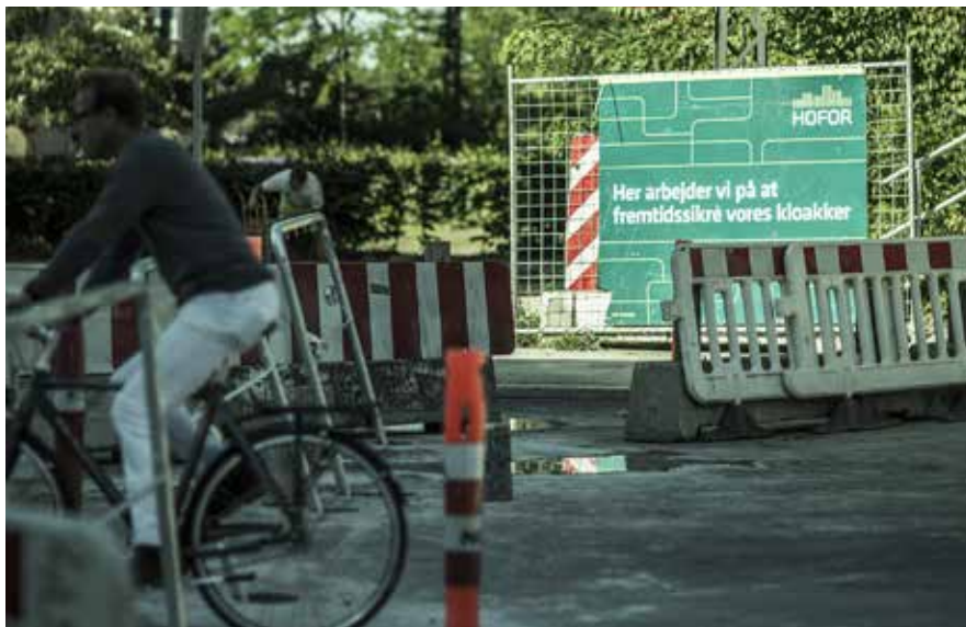
Gravearbejder er en naturlig følge af at skabe byer med bæredygtige forsyninger, og en del gravearbejder skyldes også infrastruktur ændringer som metro og letbane.
