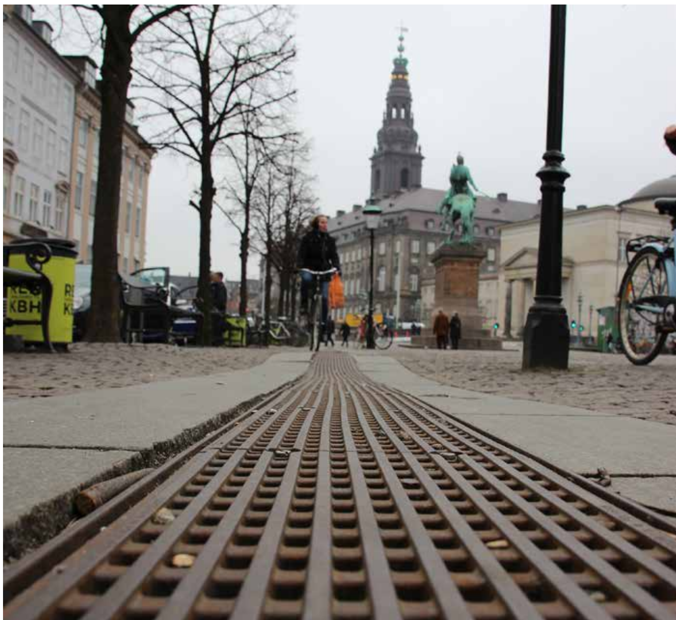
Skybrudsriste i indre København var med til at forhindre, at skybruddet den 31. august 2014 fik så alvorlige følger som tidligere. Regnvandet blev ledt direkte ud i havnebassinet.
