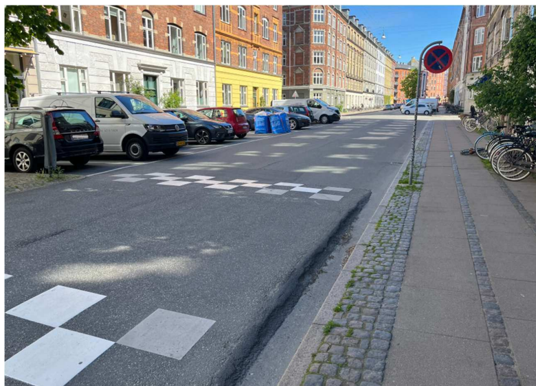
Figur 3 Bump er ikke anlagt helt ud til kantstenen og er derfor ikke en hensigtsmæssig passagemulighed for bevægelseshæmmede personer
