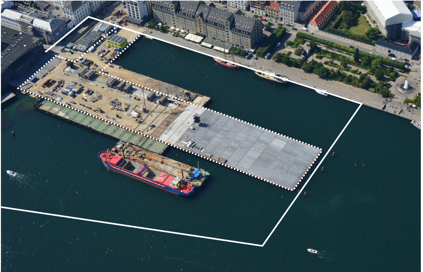
Luftfoto af området set fra øst. Lokalplan nr. 374 er angivet med hvid linje. Området for tillæg nr. 1 er angivet med hvid, stiplede linje.
