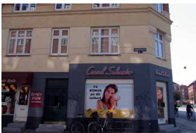
Udsnit af underfacade mod Augustagade
