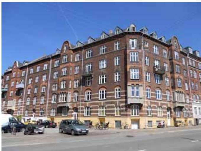
Facade mod Godsbanegade og Ingerslevgade
