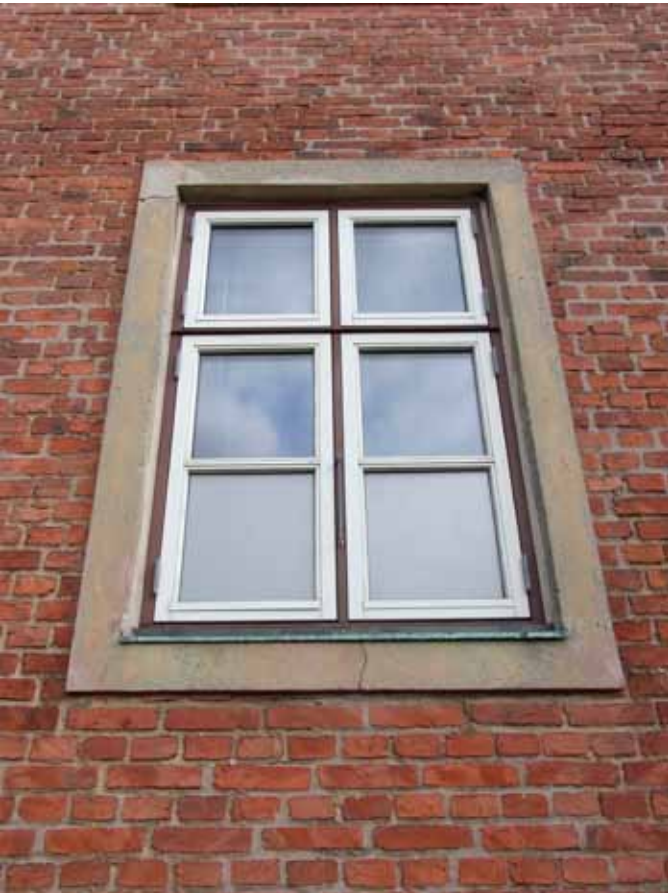
Vindue med indfatning
