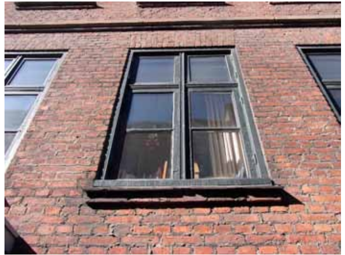
Det oprindelige vindue
