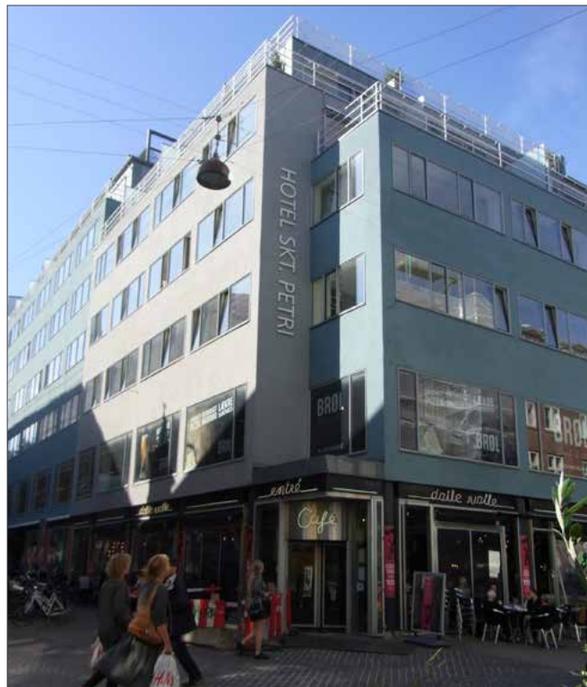
Det gamle Daells varehus på hjørnet Krystalgade/Fiolstræde. Der er ingen adgang til butiksarealerne på 1. sal, der står tomme hen.
