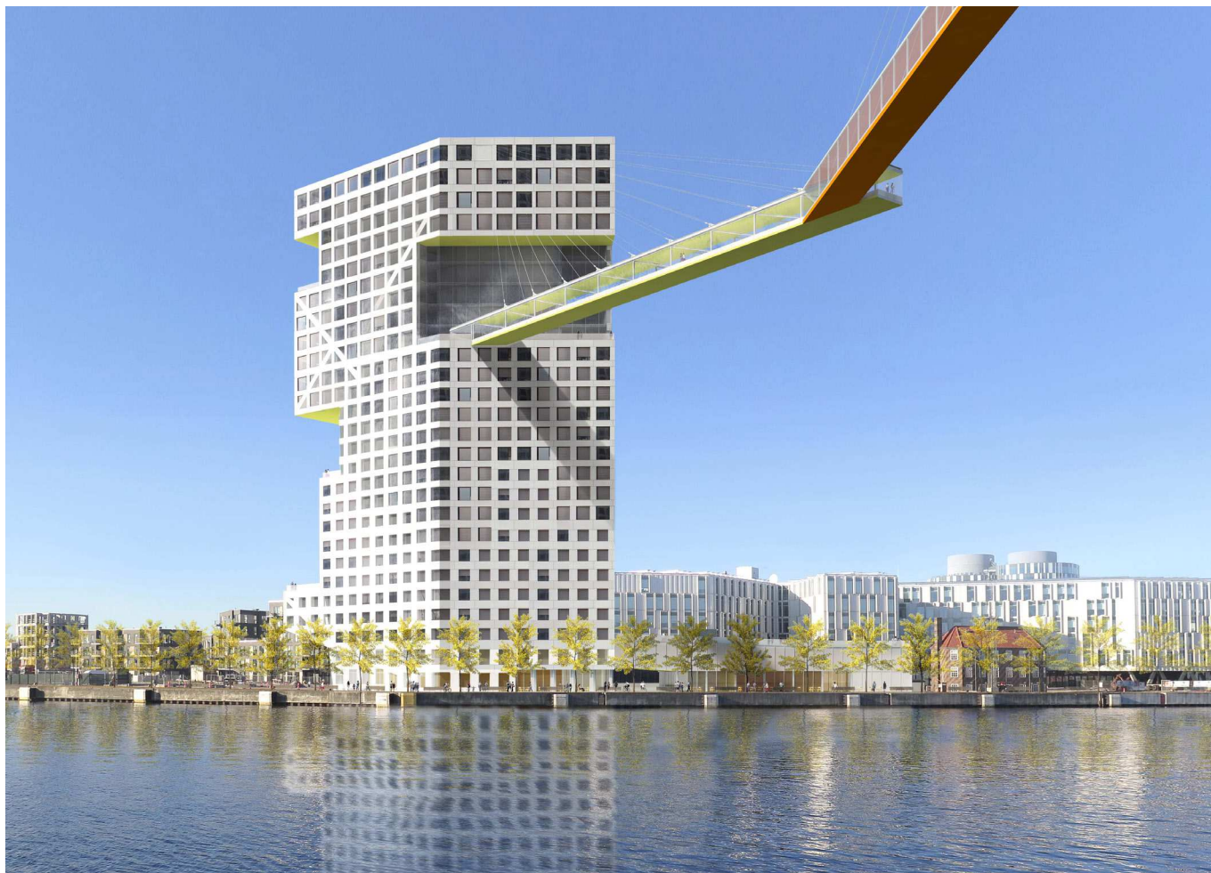
Højhuset på Marmorolen set fra Langelinie med 'Lodseriet', FN-byen og bolighalvværne i baggrunden. Ill: Steven Holl Architects.
