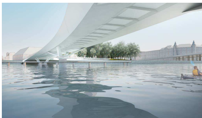
Undersiden af broen behandles som en tredje facade, som viser konstruktionens opbygning. Illustration: Wilkinson Eyre Architects.
