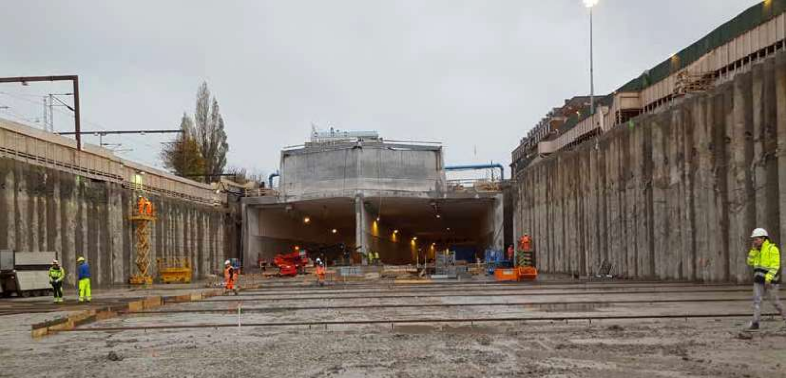
Anlægsarbejde i byggegruben for Nordhavnsvej. Foto: Københavns Kommune.
