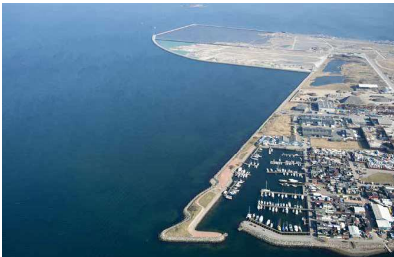
Figur 5.13 Eksisterende forhold ved Nordhavns Nordspids. Luftfotoet er taget mod øst.
