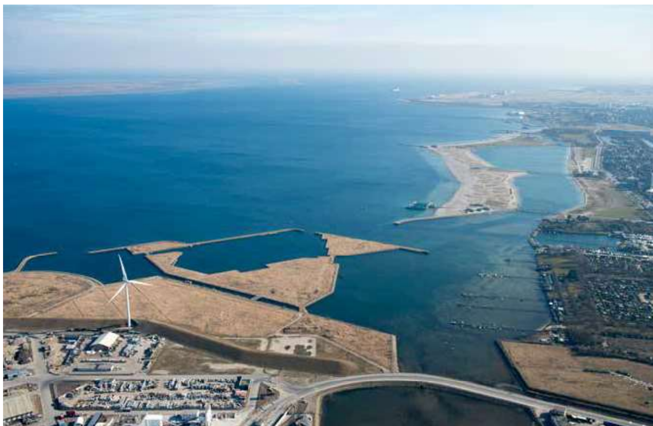
Figur 5.16 Eksisterende forhold ved Prøvestenen. Luftfotoet er taget mod sydøst.
