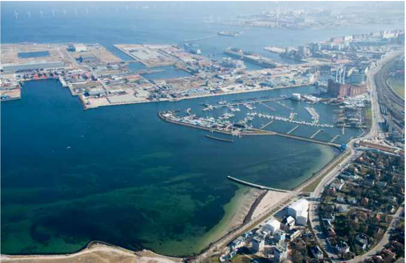
Figur 5.4 Eksisterende forhold i Svanebølbugten. Luffotoet er taget mod sydøst.
