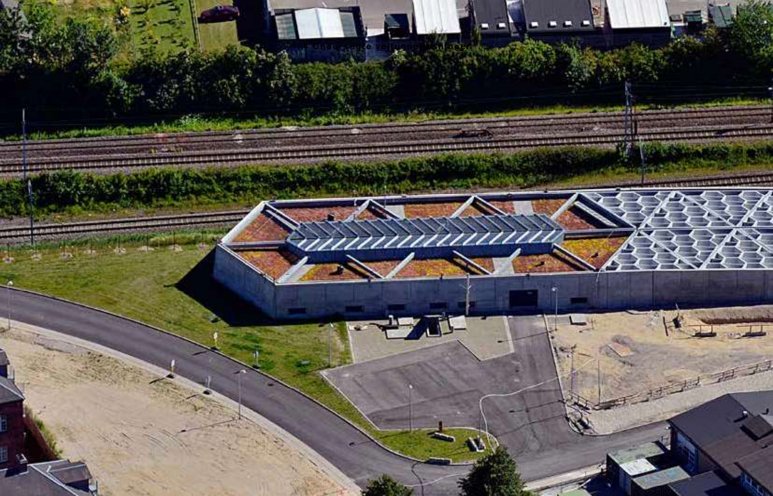
Teknikhus og dagslysskærm for Nordhavnsvejtunnelen.
