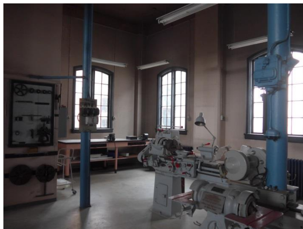
Sidefløjen til maskinhallen med gamle installationer
