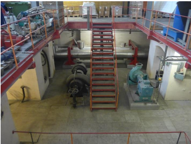
Åbning til kælderen under maskinhallen
