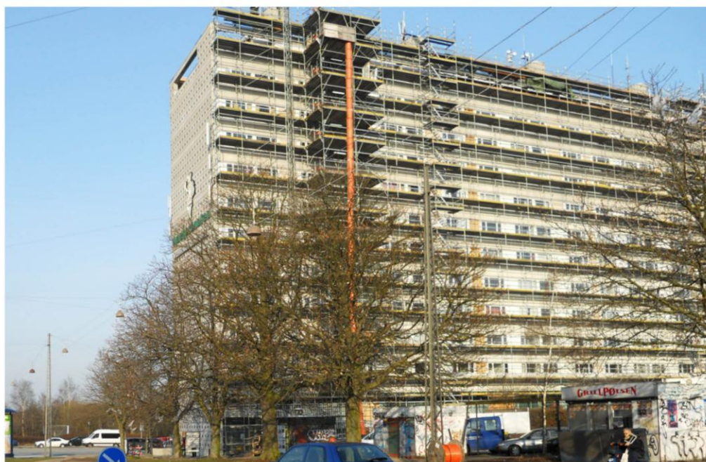
Kollektivhuset under reovering
