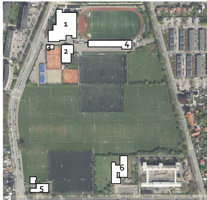
Figur 15: Luftfoto af Sundby Idrætspark
