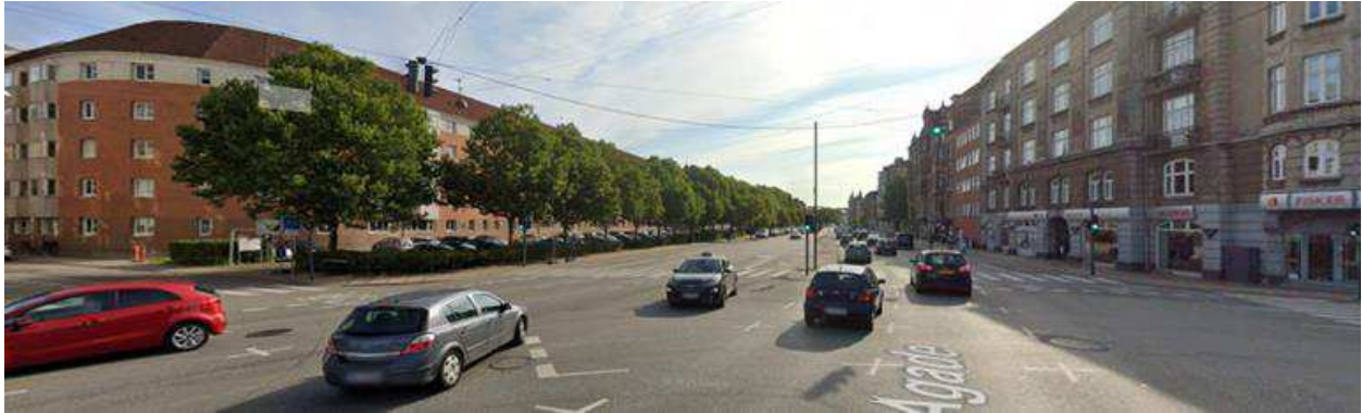
Figur 3-34 De opstrammede træer i gaderummet ved Jægergade.
