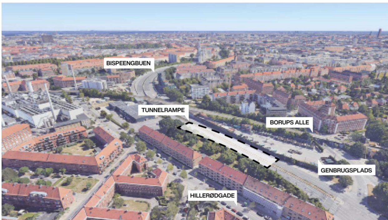
Figur 5-20 Rampe vest mellem Borups Allé og Ringbanebroen
