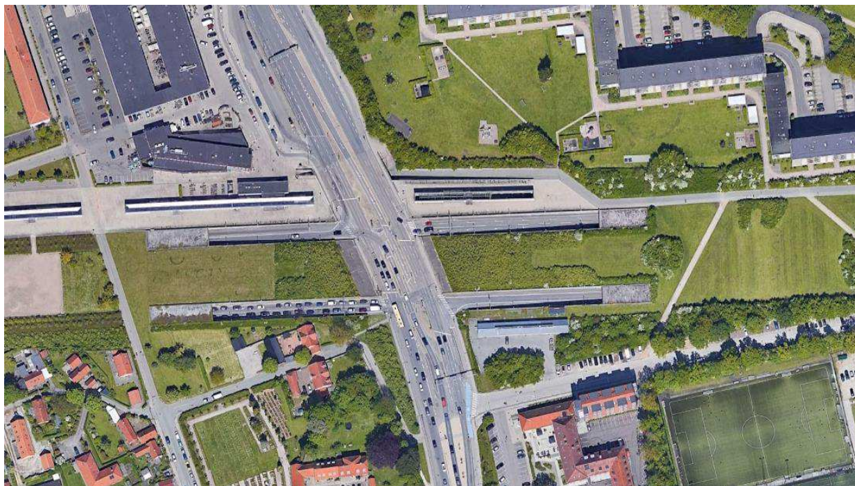
Figur 8-5 Tårnbyoverdækningen. Sideramper tilslutter til Engelsvej. Bemærk udbredelse af svingbaner Nord og Syd for tunnelen for at sikre en effektiv trafikafvikling (Google Earth).
