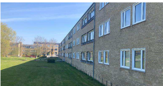
Foto: Eksisterende boligbebyggelse der påbygges yderligere tag-etage. Set fra haverum ved Åkandevej set mod nord.
