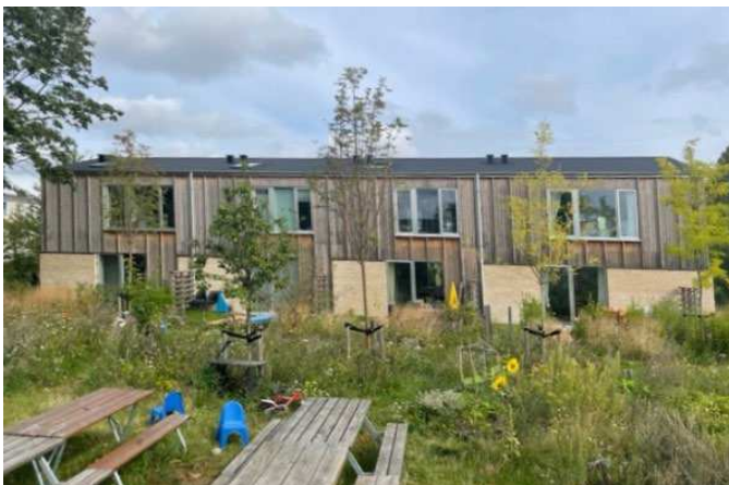
Nye rækkehuse ved Skolesiden set fra syd.
