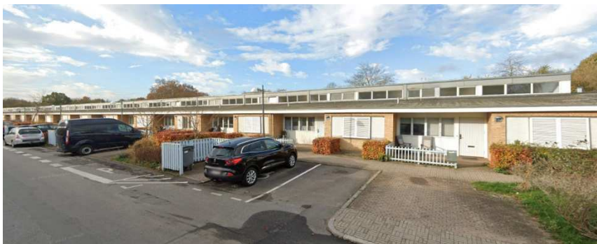
Udsnit af rækkehusets nordlige østfacade
