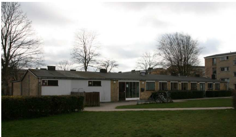
Den fritliggende fløj set fra nord
