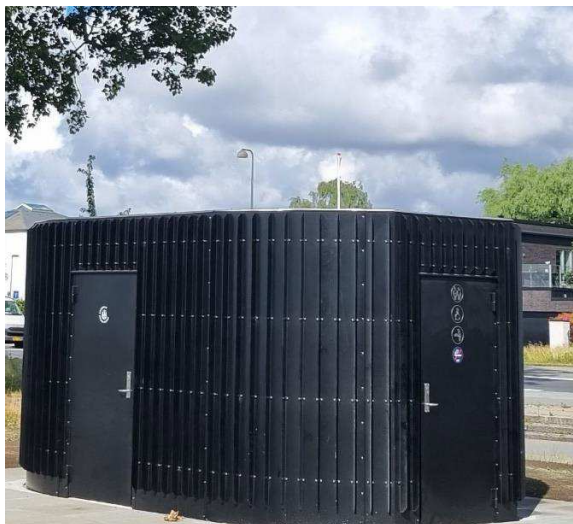
Standardtoilet på Amager Strandvej
