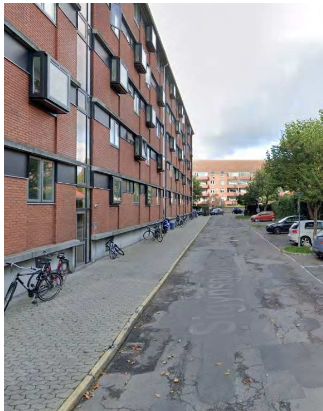
Vognvænget set fra Sigynsgade stikvej
