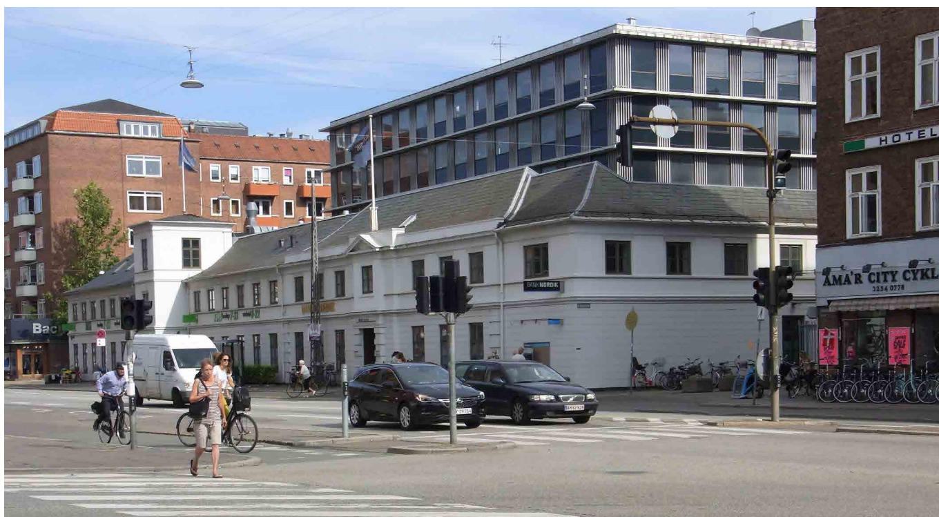
Lokalplanområdet set fra Amagerbrogade. I forgrunden Amagerbankens tidligere hovedsæde, en klassicistisk bygning fra 1850. Bagved ses den 6. etagers kontorbygning fra 1972, der nu ønskes omdannet til ungdomsboliger. Foto: Københavns Kommune.
