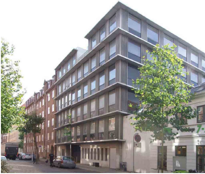
Foto af de eksisterende forhold. Foto: Københavns Kommune.
