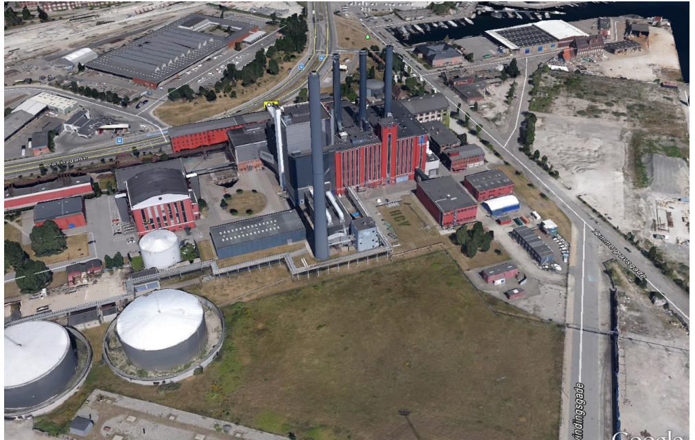
Figur 9: Oversigt over H.C. Ørstedsværket set fra Elværksvej (Google Earth Pro, 2016).
