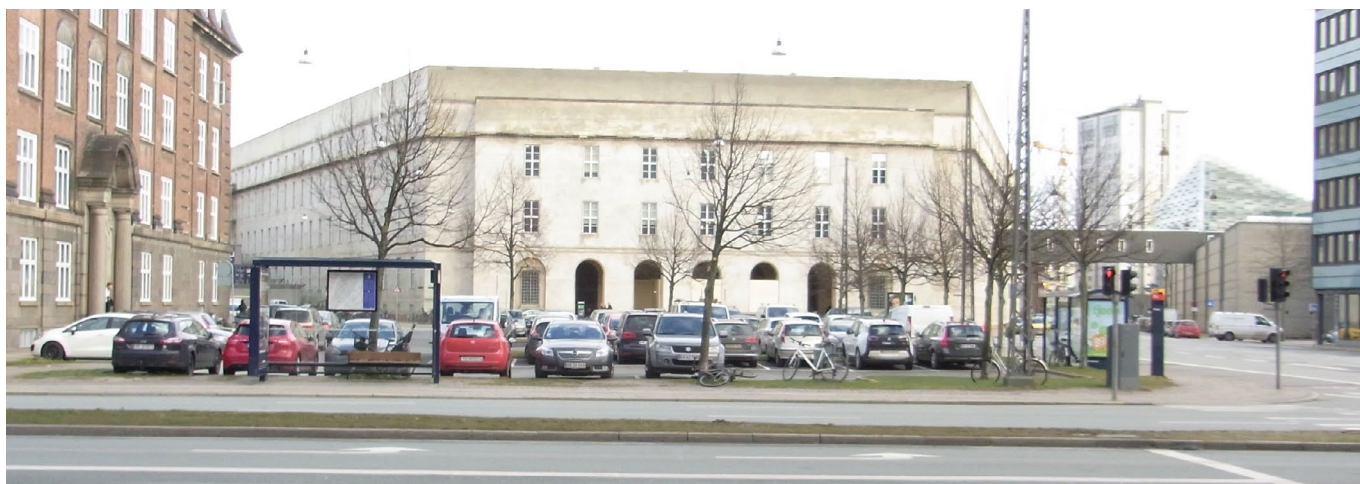
Polititorvet foran Københavns Politigård, som er fra 1924 og er tegnet af arkitekterne Hack Kampmann og Holger Alfred Jacobsen. Politigården er kendt som den sidst opførte ny klassicistiske bygning i Nordeuropa og er karakteriseret ved den ensartede og lukkede facade. Foto: Københavns Kommune.
