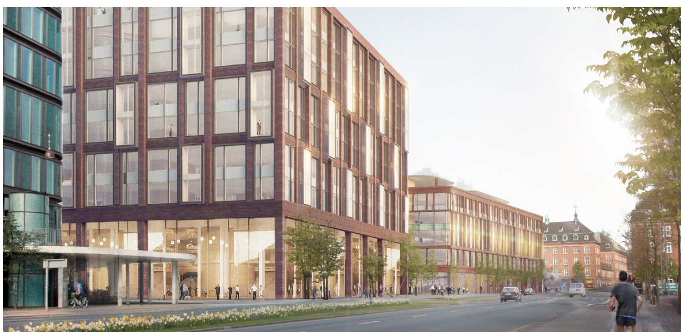
Centralpostbygningen i sammenhæng med den ny bebyggelse set fra havnen. Illustration Lundgaard & Tranberg
