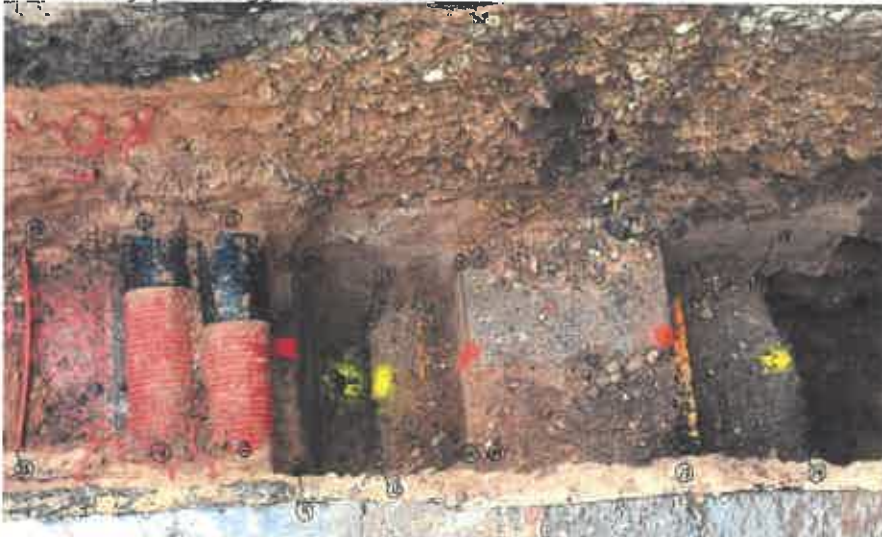
Billede 1. Foto af udgravning af Radius' 30 kV og Energinet.dk's 132 kV kabelanlæg i Trangravsvej. Fotoet er taget mod vest, således at nord er i fotoets højre side. 132 kV kablet HK1211 er kabelkassen i fotoets højre side, markeret med gul spray.
