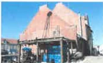
Kedel og Maskinhus fra 1909.
