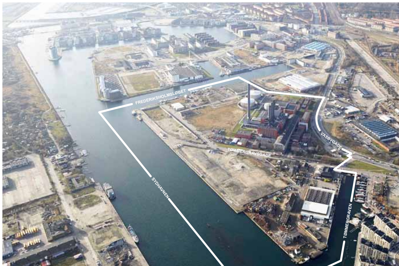
Luftfoto af Enghave Brygge set mod sydvest. Teglnholmen og Sluseholmen ses i baggrunden. JW Luftfoto 2009.
