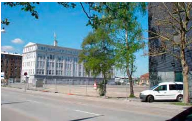
Bevaringsværdig bebyggelse Holmbladsgade 111
