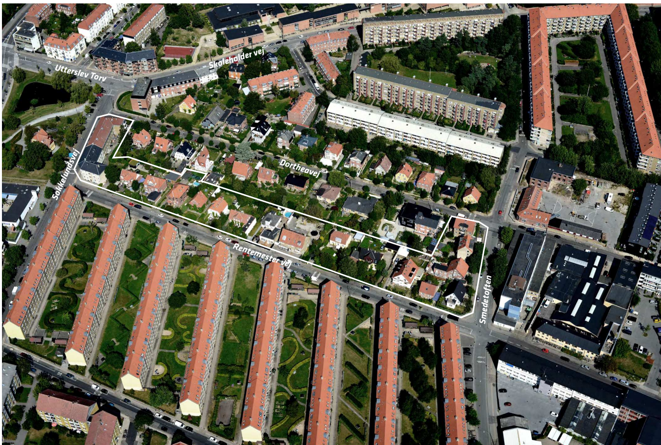
Luftfoto af lokalplanområdet set fra syd
