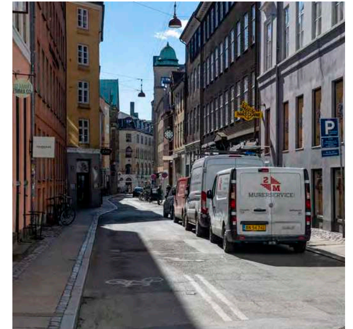
Billedet viser Klosterstræde. Med projektet anlægges gaden med let udvidede fortove og med brolægning på kørebanelen. Foto: Troels Heien (2021)
