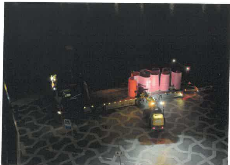
02.30 opstilling af toiletter
